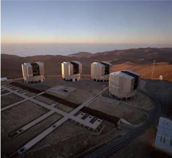
Das Very Large Telescope (VLT) auf dem Paranal im Norden Chiles. Es wird von der ESO betrieben. Die vier Großteleskope und einige kleinere bewegliche Teleskope lassen sich zu einem Interferometer („Lichtwellenaddierer“) verbinden. (ESO)
